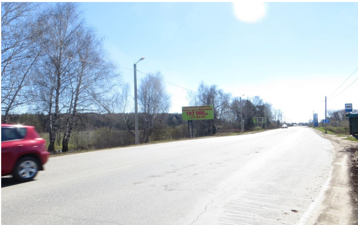
17. МО «Завьяловское», автодорога (Ижевск-Аэропорт) - Завьялово, км 0+100, слева – РК 1.27
